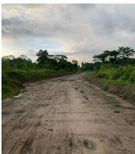
Gambar 1. Akses Jalan antardesa
